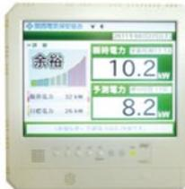
そんな中、わが社では6月から、電力使用量の見える化に取り組んでいます。関西電気保安協会様からご提案をいただきデマンドコントローラーを設置しました。デマンドコントローラーは電気の使用量を見張るデマンド監視システムで、使用料の規定のラインを超えると警報により知らせてくれます。
